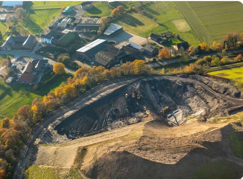
Giftmülldeponie Kamp-Lintfort, Luftbild 2017
