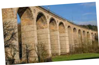
Viadukt in Altenbeken
