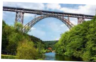
Müngstener Brücke zwischen Remscheid und Solingen
