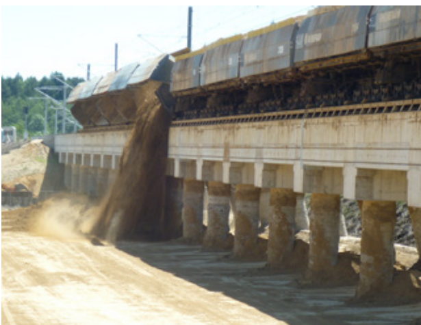
Bild 14.1 – Entladungsvorgang am Kippgraben Hambach (Quelle: Bezirksregierung Arnsberg)
