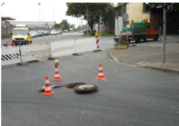
Bild 9.4 – Zugangsschacht in der Wetterstraße (Quelle: Fichtner Water & Transportation)
