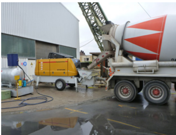
Bild 11.4 – Anlieferung Transportbeton (Quelle: Bezirksregierung Arnsberg)
