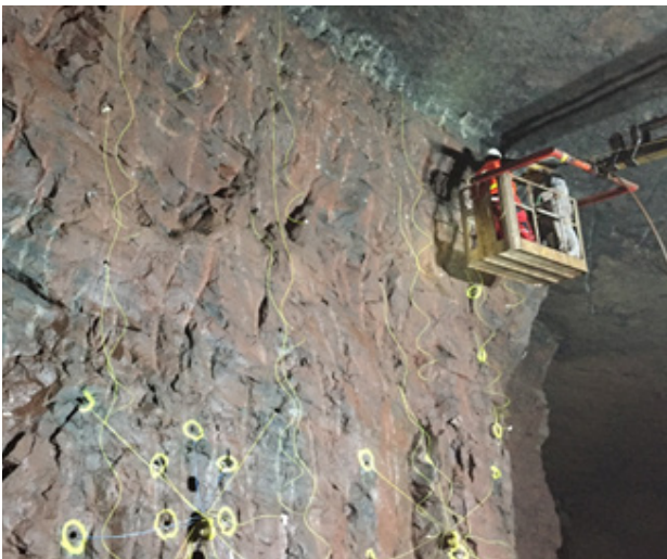
Bild 10.3 – Besetzarbeiten (Quelle: Barbara Erzbergbau GmbH)
