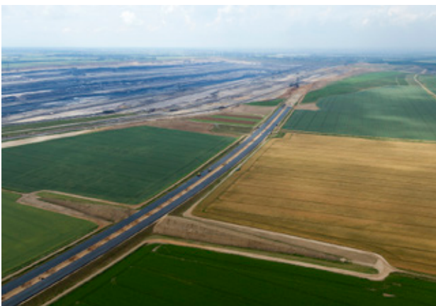
Bild 6.4 – Bauphase im Jahr 2016 mit Blick auf die Teststrecke Richtung Norden (Quelle: RWE Power AG)
