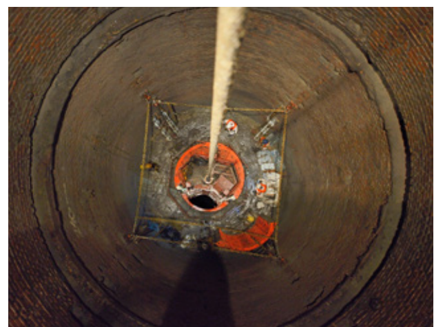
Bild 11.3 – Montage der Arbeitsbühne (Quelle: RAG AG, Servicebereich Technik- und Logistikdienste)
