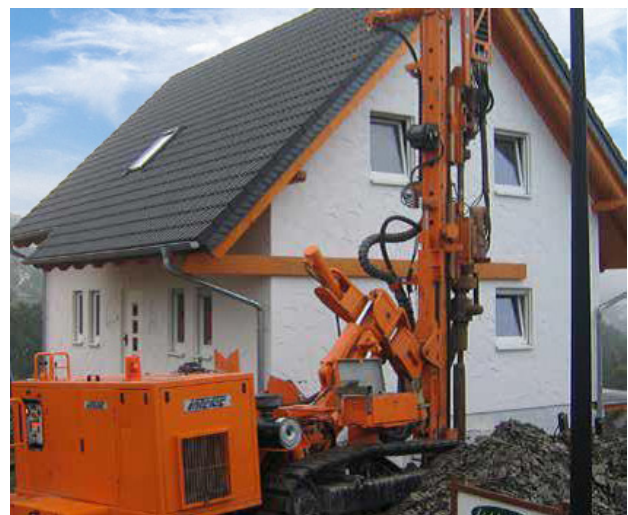
Bild 2.4 – Geothermiebohrung (Quelle: H. Spiekermann Bohrtechnik GmbH)
